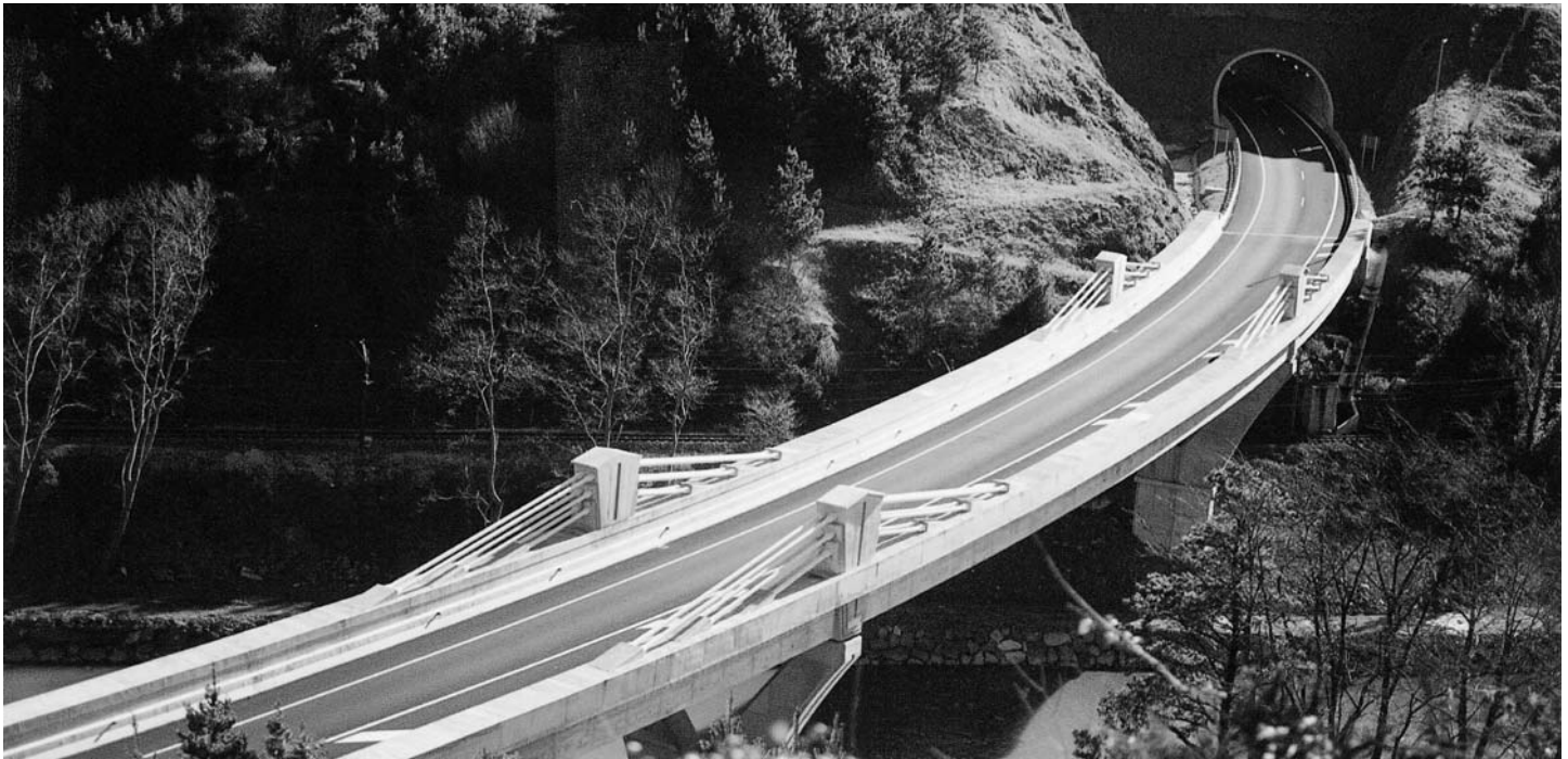
Fig. 2. Puente sobre el río Deba. Vista superior.
