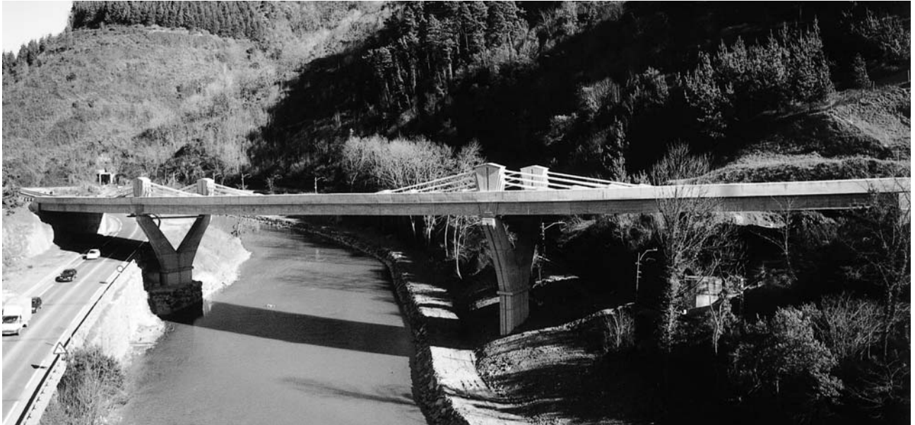
Fig 1 .Puente sobre el río Deba. La fotografía muestra el paso de la Carretera N-634 por debajo del tablero.
