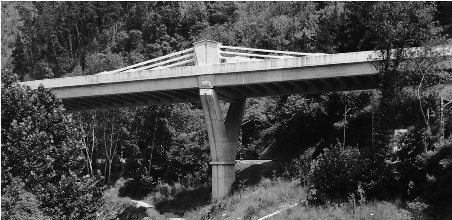
Fig. 4. Aspecto del conjunto formado por una de las pilas y el pretensado extradosado que atraviesa el pylon, de escasa altura.
