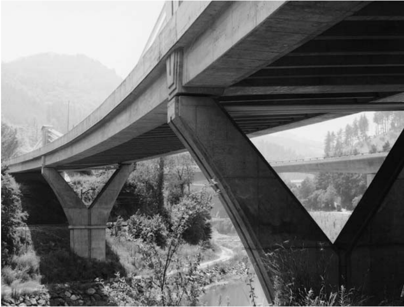
Fig. 3. Aspecto de la parte inferior del tablero.
